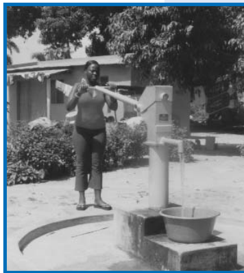
Exemplo de poço e furo de água construídos
